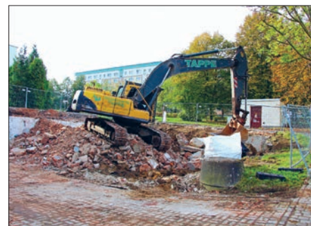
Mitte Oktober thronte noch der Abrissbagger auf den Resten des ehemaligen „Block 21“ an der Straße zur Baumwolle im Wohngebiet „Sattelgut“. Foto: rs.
